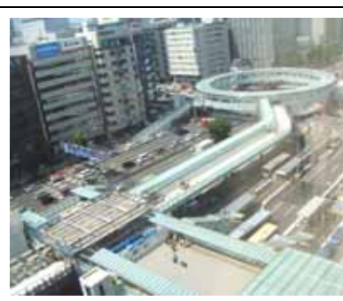
新横浜駅前の円形歩道橋 もう少して完成のようです。
